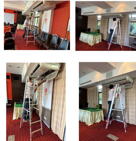
ทำความสะอาดเครื่องปรับอากาศ ห้องปฎิบัติงาน
