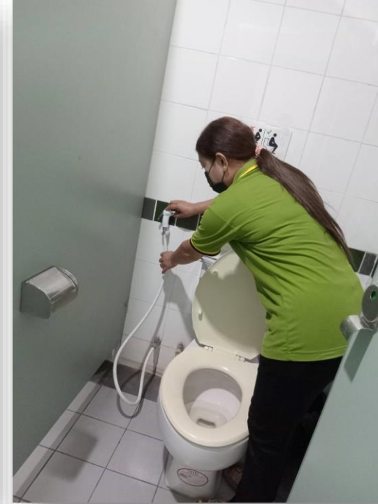
ตรวจสอบการรั่วซึมของท่อน้ำ ก๊อกน้ำ และสายชำระ
