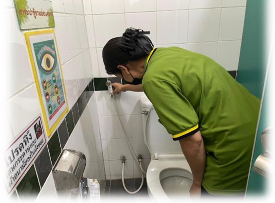
ตรวจสอบการรั่วซึมของก๊อกน้ำและสายชำระ
